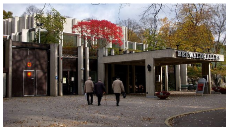
PLS-700 finns installerade i Berwaldhallen i Stockholm
